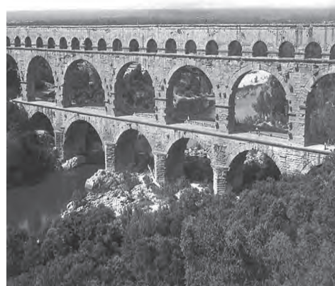
चित्र 2.5: नाइम्स के पास पान दु गार्ड, फ्रांस, प्रथम सदी ई. रोम के इंजीनियरों ने तीन महाद्वीपों के पार पानी ले जाने के लिए विशाल जलसेतुओं (Aqueducts) का निर्माण किया।
